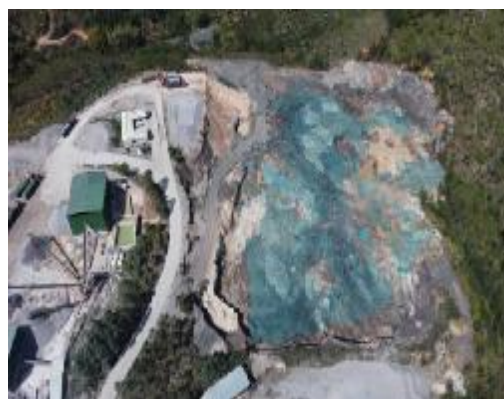
施工过程中临时覆盖
